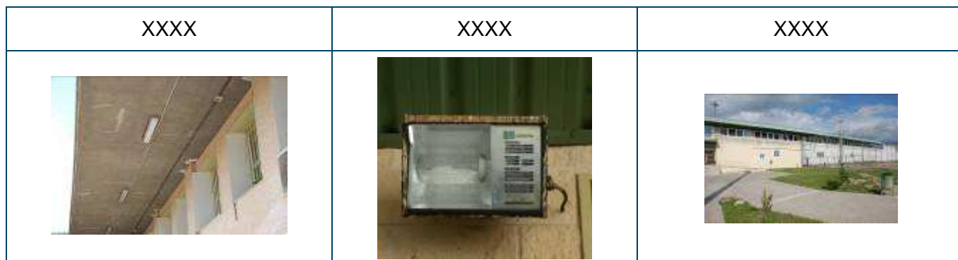
Figura 2 Imagen de Iluminación Exterior
