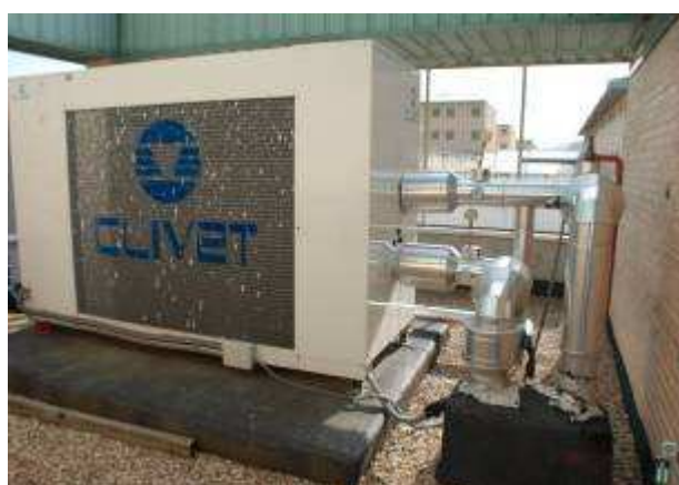
Figura 9 Imágenes de Grupos con Bombas de Calor
